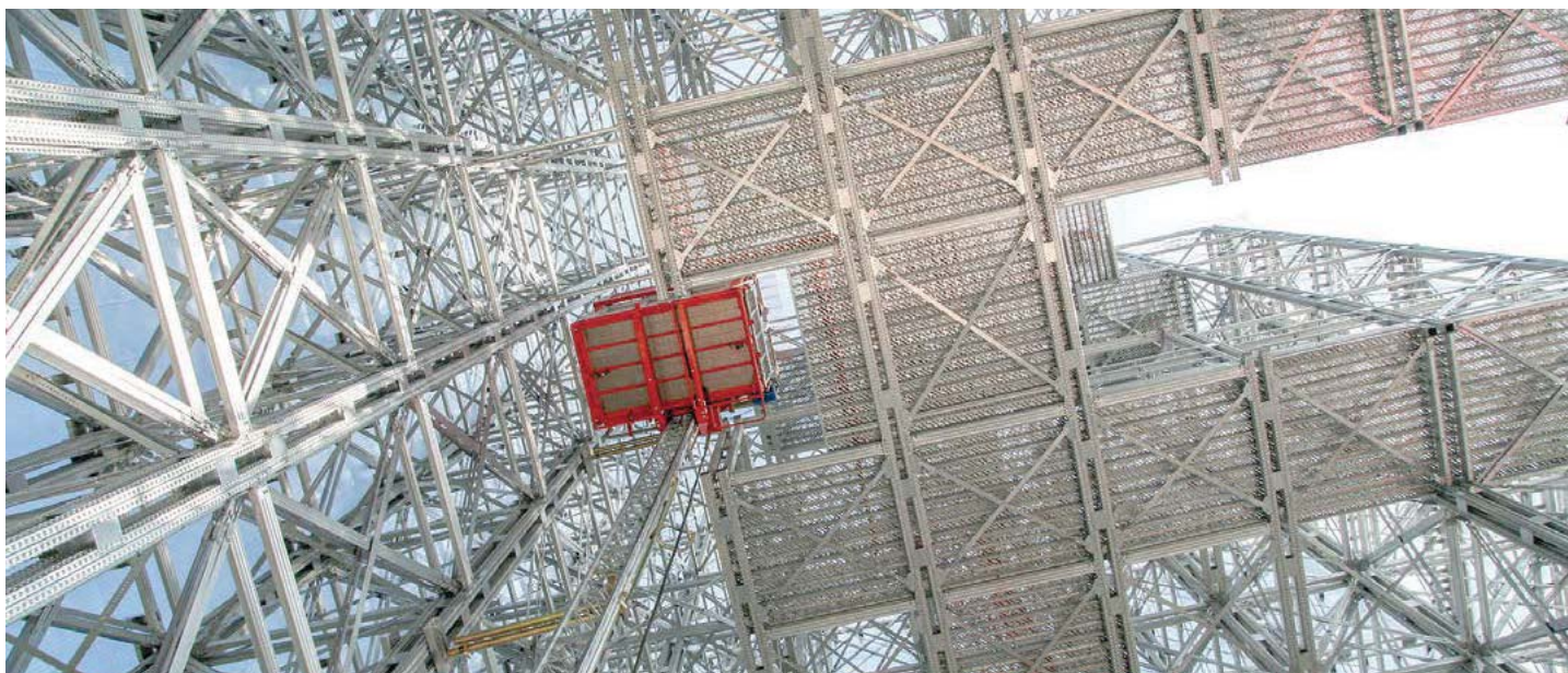
Fig. 7 – Passerelle di servizio
