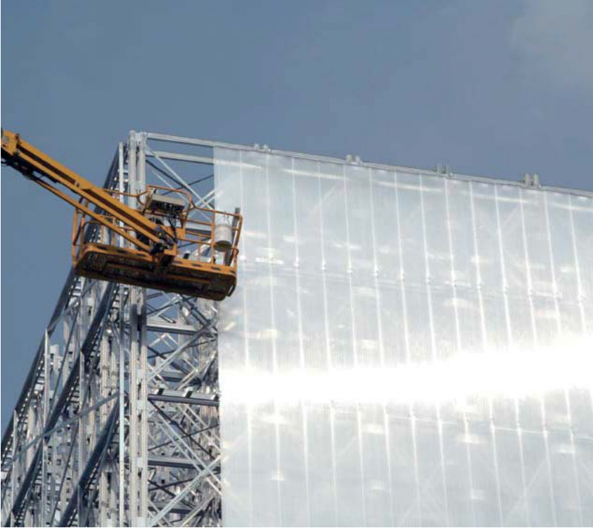
Fig. 8 – Applicazione del rivestimento in policarbonato
